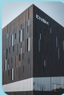
Site du Havre 10 quai Frissard 76600 Le Havre
